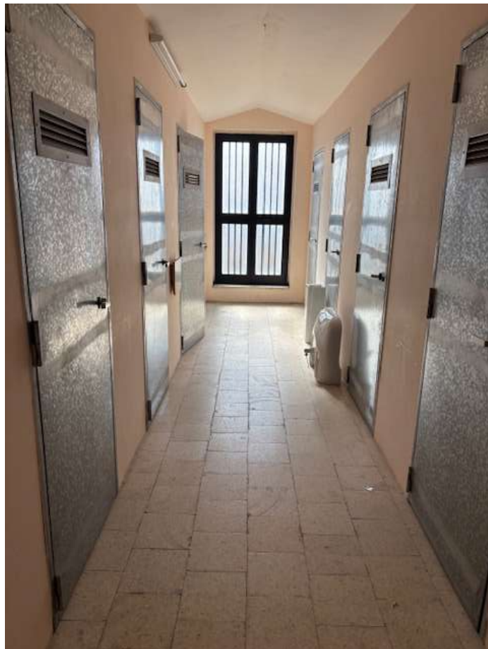
Foto n. 25 – Sottotetto e disimpegno alle varie unità pertinenziali – locale pertenziale con accesso dalla terza porta a sinistra
