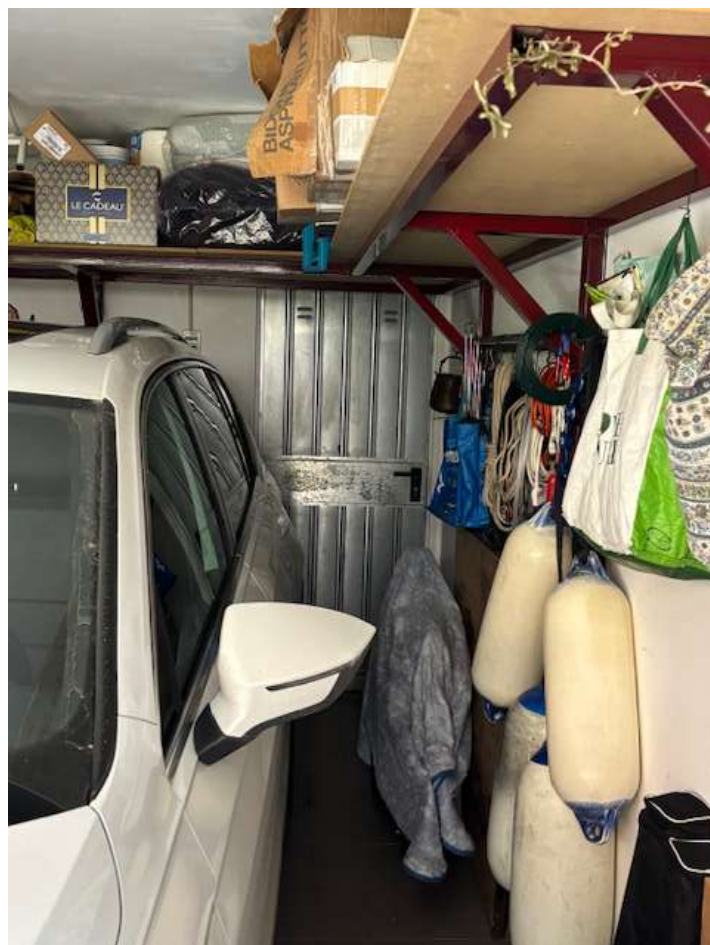
Foto n. 30 – Porta di accesso pedonale al box dal vano scala
