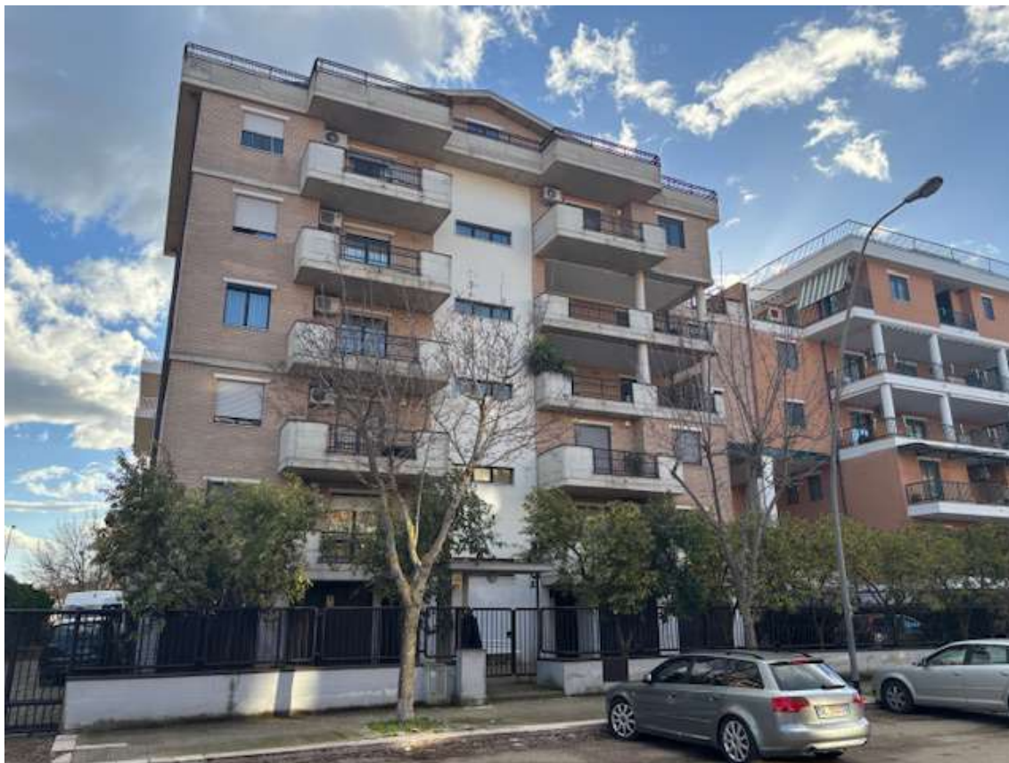
Foto n. 1 - Prospetto principale dell'edificio su Via Mario Carli
