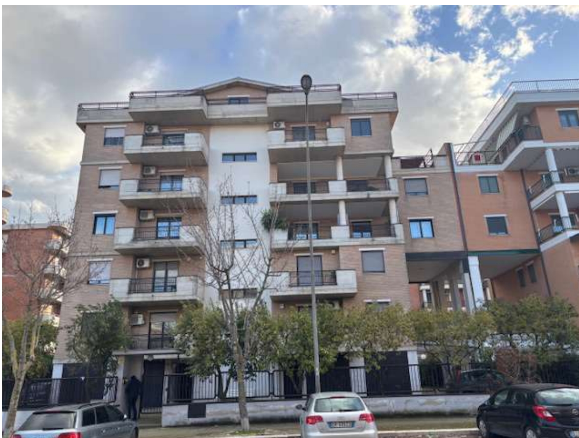
Foto n. 2 - Prospetto principale dell'edificio su Via Mario Carli
