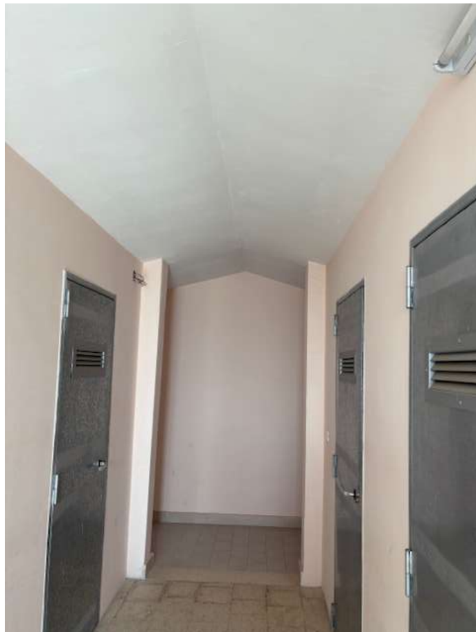
Foto n. 27 – Sottotetto e disimpegno alle varie unità pertinenziali – vista verso il vano ascensore
