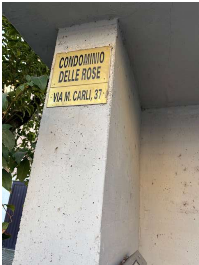
Foto n. 3 – Accesso condominiale dal civico n. 37 di Via Mario Carli
